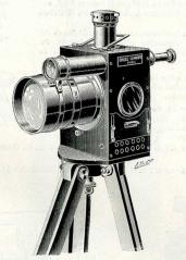
Appareil de télégraphie optique portatif de 10 centimètres (diamètre des lentilles). 1/5° de la grandeur.
